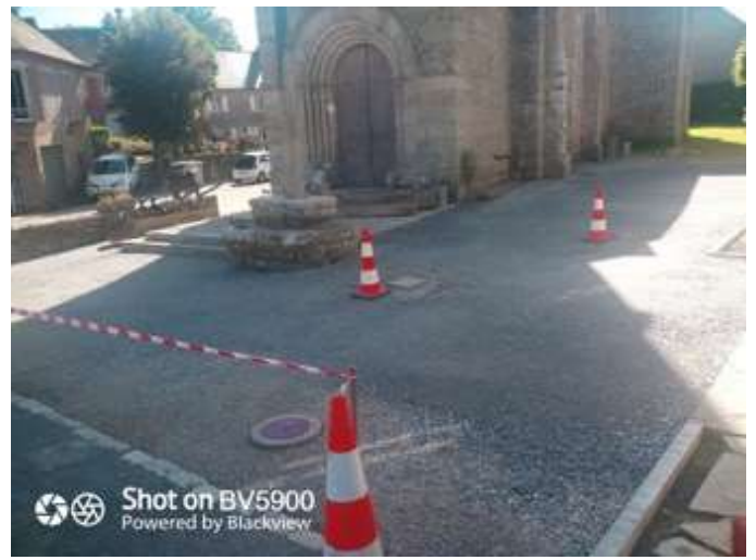
Travaux sur la place de l'église (pendant)
