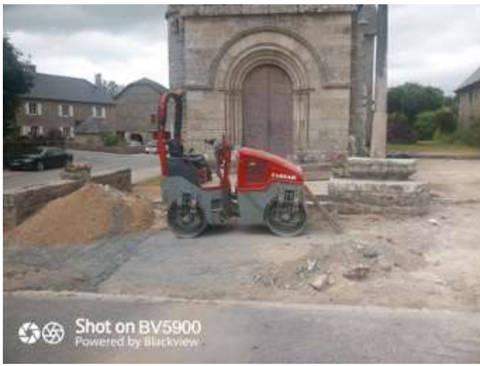
Travaux sur la place de l'église (pendant)
