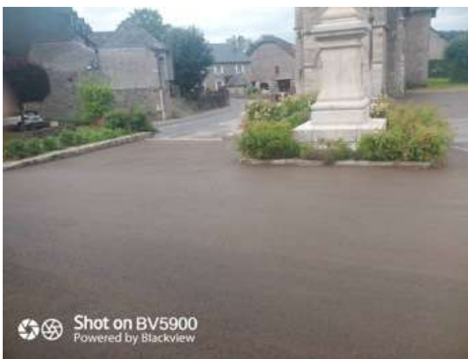
Travaux sur la place de l'église (après)
