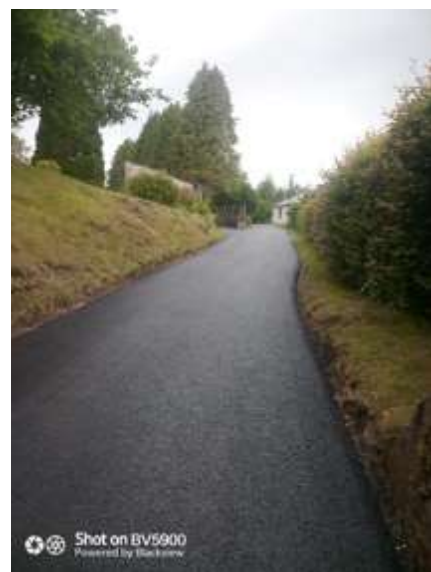
Réfection de l'impasse de la Roubière Carrée
